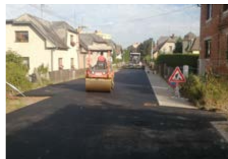
Přeložený chodník, nový asfaltový povrch a nové veřejné osvětlení má od léta první úsek ulice Na Struhách .
