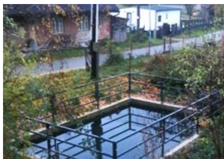
Díky podpoře Královéhradeckého kraje byla opravena vodní nádrž na Merklovickém potoce . Dostala zejména nové bezpečné zábradlí, repasované je stavidlo. Nádrž slouží pro čištění zatrubněného toku.
